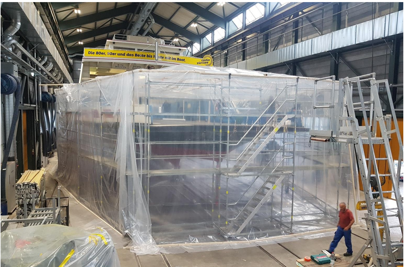
Bereit für Sandstrahlung vom Rumpf und Fahrbahndeck (12. Juli 2023)
