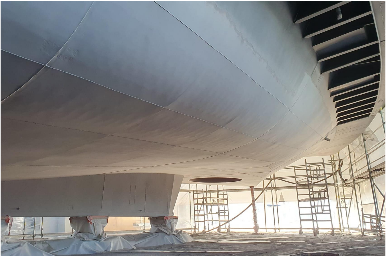
Frisch sandgestrahlt – Bereit für das Auftragen der sechs notwendigen Farbschichten (14. Juli 2023)
